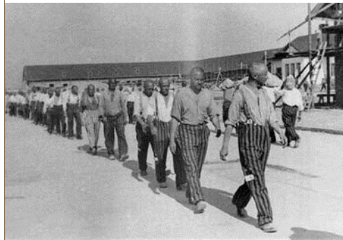
In marcia per i lavori all'esterno
