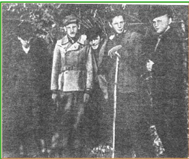
Comandanti in clandestinità del gruppo Zawisy di Varsavia denominato "ZIEM ZACHODNICH" (Terra dell'Ovest)
